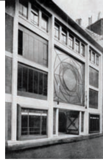
1905 Garage at 51 Rue de Ponthieu Auguste Perret
